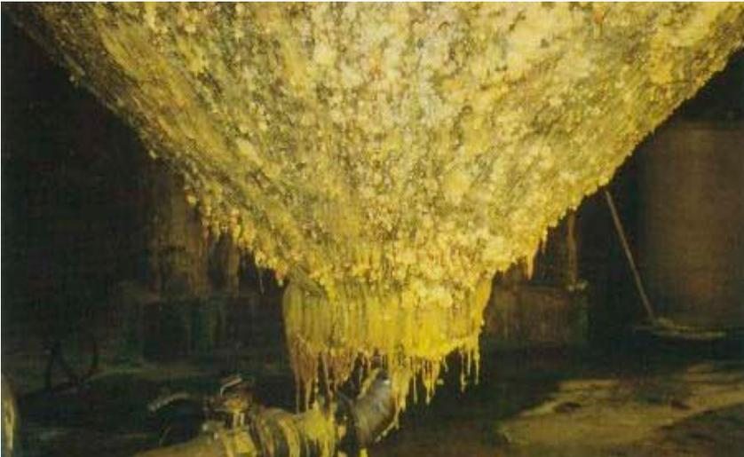
Nach einer Sandstrahlbehandlung der Innenwände wurden Fugen und Risse erweitert. Anschließend wurde der Tank über eine Zeitspanne von 4 Wochen mehrmals mit sauberem Wasser aufgefüllt, um möglichst viele Natriumchlorat-Anteile aus dem Beton zu spülen. Die Fugen und andere Schadensstellen wurden im Anschluss daran mit XYPEX repariert. Auf die Wände des Behälters wurden mit einem Quast sowohl innen als auch außen zwei Schichten XYPEX-CONCENTRATE aufgetragen.
