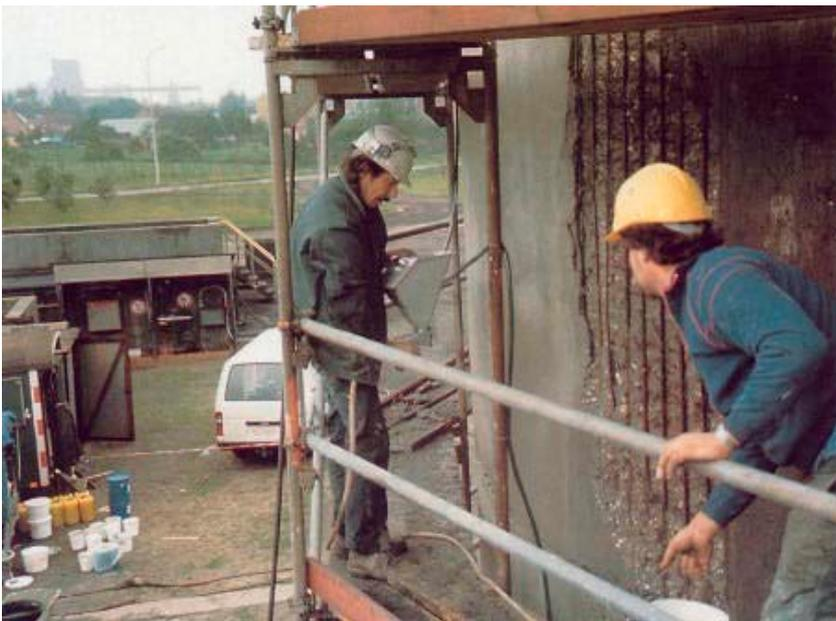
Die Verwendung der XYPEX-Sanierungsprodukte stoppte alle Undichtigkeiten und verhinderte eine weitere Korrosion der Bewehrung. Die Lebensdauer des Bauwerks wird auf diese Weise um einige Jahre verlängert.
